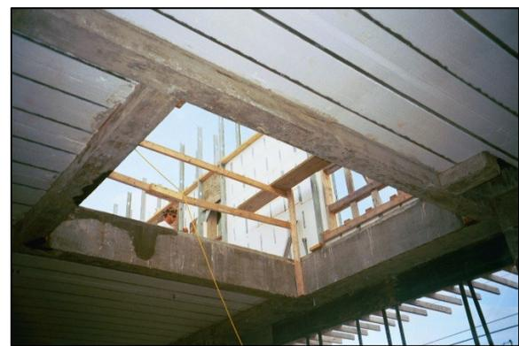
*Encofrado y cimbra del hueco de escalera; antes del vertido Vertido del hueco de escalera; encofrado y cimbra retirados*
