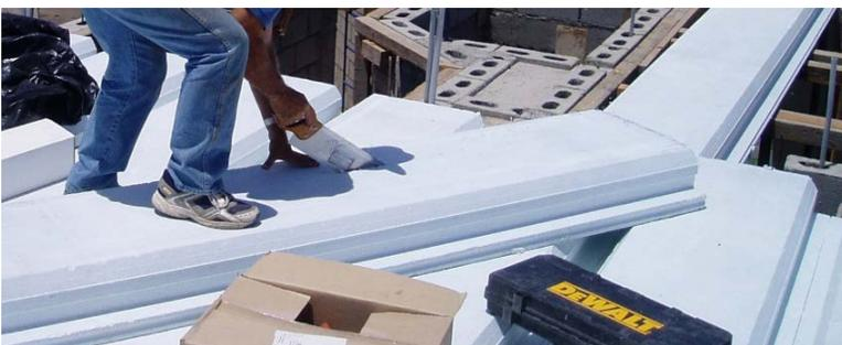
Uso de una sierra de mano para cortar un panel Quad-Deck longitudinalmente (arriba) para dimensionar correctamente un panel rasgado (derecha).
