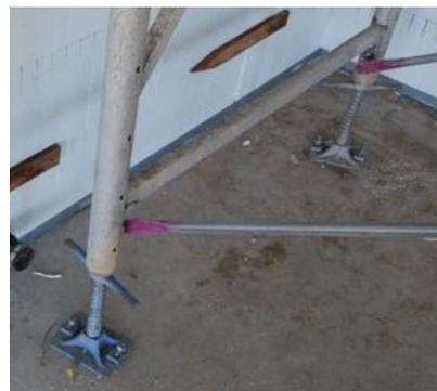
*Placas base ajustables que soportan el bastidor en H sobre la losa de hormigón*
