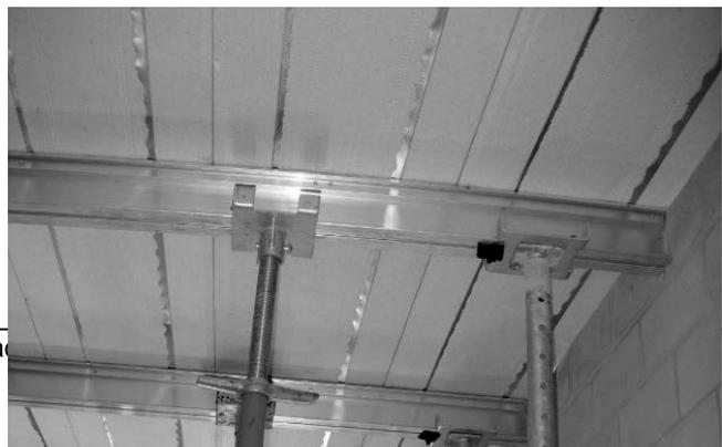
no más de 5'-6' [1.5-1.8m], comenzando a no más de 6" [152mm] de los extremos del panel. Utilice una separación de 1-1,2 m [3-4'] para losas más gruesas y/o cargas de construcción más pesadas.
