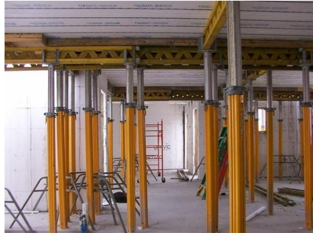
*Estructuras en H de acero que soportan vigas en I de aluminio Postes de apuntalamiento que soportan vigas de madera de ingeniería*
