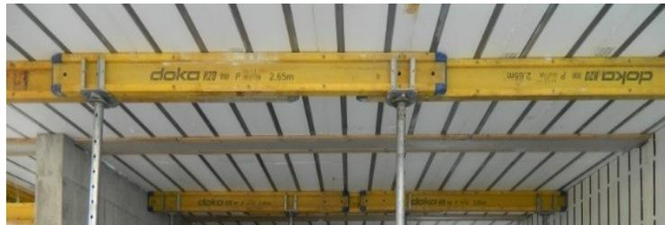
*Secciones de vigas de entibación de aluminio Vigas de entibación de madera laminada apoyadas en postes de entibación*
