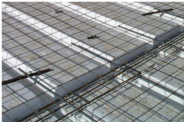
Corte de una nervadura transversal en EPS con una cortadora de arco de alambre caliente. Acero de refuerzo y malla instalados en una nervadura transversal.
