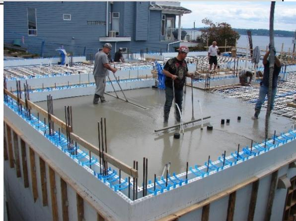
Las cuadrillas colocan el hormigón autocompactante sobre los encofrados Quad-Deck
