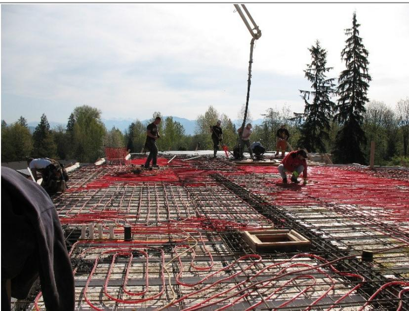
*Suelos radiantes instalados sobre malla soldada*
