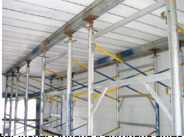
**La instalación de la entibación debe ser inspeccionada y aprobada antes de su uso y antes de la colocación del hormigón.**
