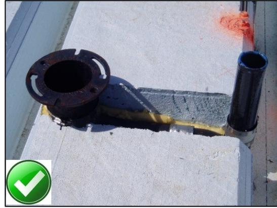
*Dos ejemplos de instalación correcta de tuberías de desagüe y respiraderos en un conjunto Quad-Deck*
